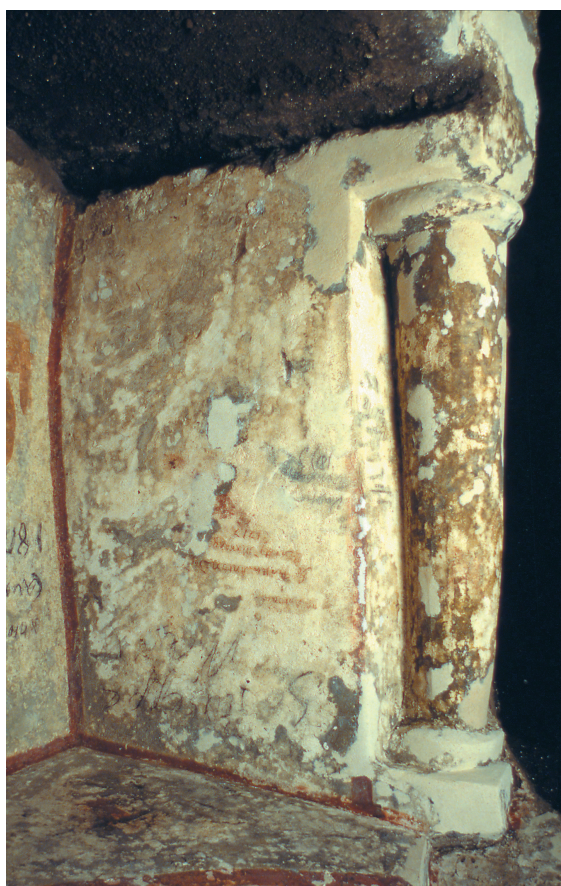
Fig. 8: Cubicolo dei Bottai: particolare della parete sinistra del coronamento della sepoltura di fondo durante il restauro (foto: PCAS)
