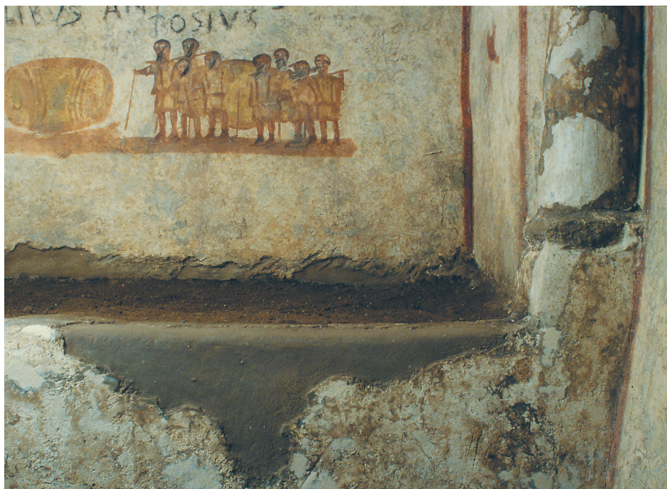
Fig. 9: Cubicolo dei Bottai: particolare della stuccatura di restauro che risarcisce il parapetto della sepoltura di fondo (foto: PCAS)
